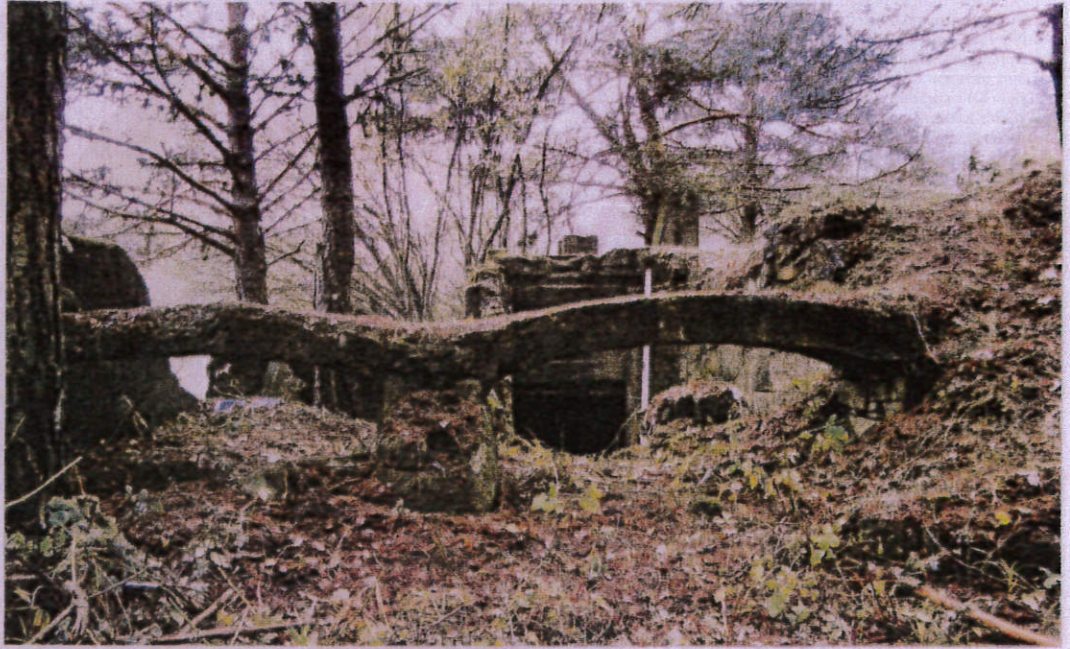
Vista exterior del conjunto, semioculto entre la vegetación del entorno. / FOTOS: C.E.M.M
